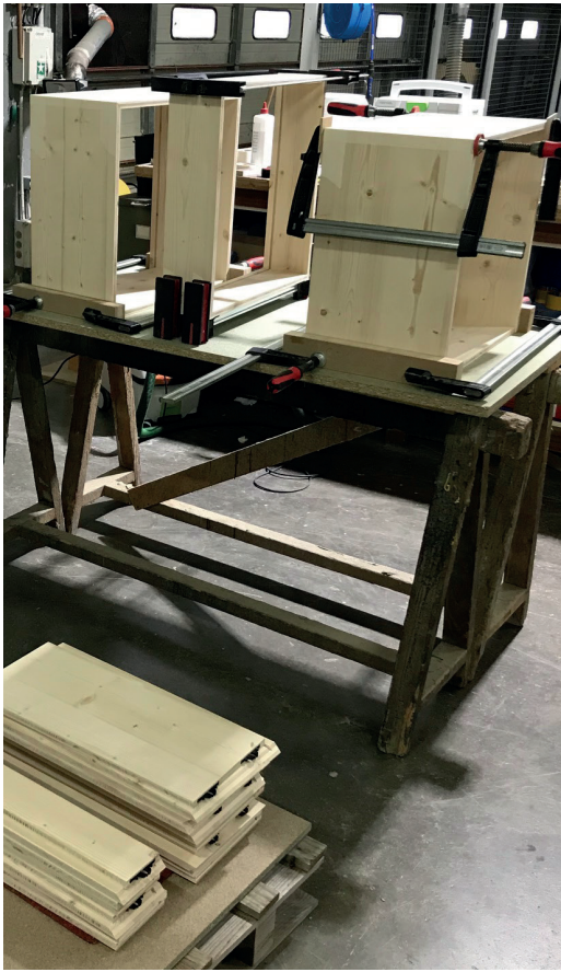
SALON COTE ENTREE Fabrication des caissons du mobilier Usinage des planches pour le mobilier Karl Fournier et Felix Hegenbart Séparation entre l'entrée et la cuisine
