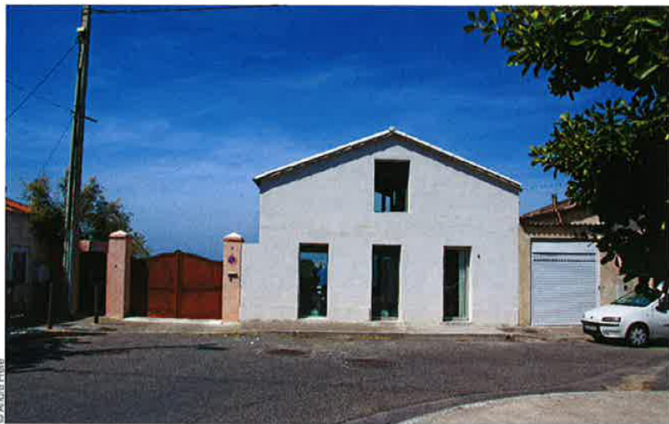
L'intervention sur la façade sur rue est modérée, se résumant à un agrandissement des baies existantes par suppression de leurs allèges afin d'accroître la circulation de la lumière du midi dans l'habitation.
