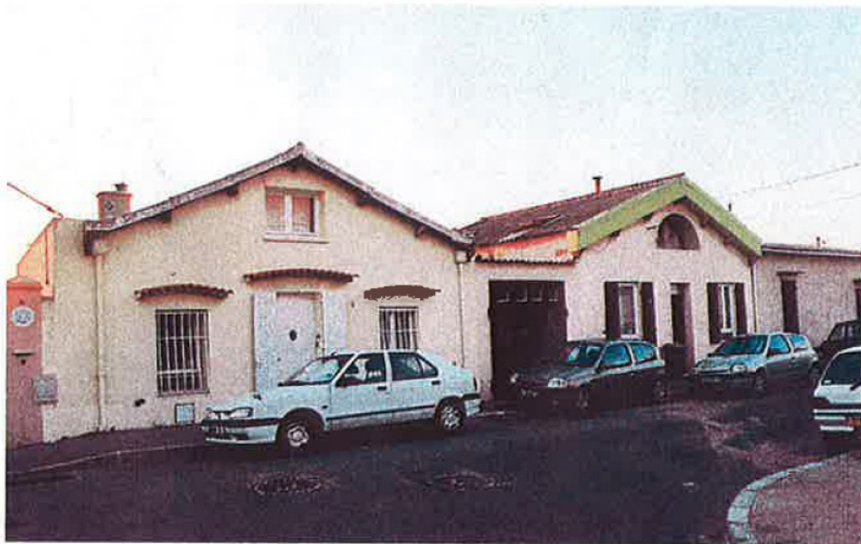
Façade sud, sur rue, du projet avant travaux : un cabanon de la fin des années 1940, fraîchement repeint, mais mal isolé, coiffé d'une couverture en amiante-ciment et défavorisé par un plan dont les cloisonnements engendrent des pièces confinées, amputées de la vue et de la lumière.
