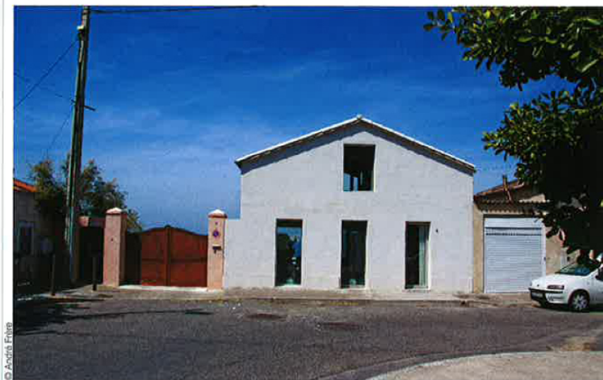
L'intervention sur la façade sur rue est modérée, se résumant à un agrandissement des baies existantes par suppression de leurs allèges afin d'accroître la circulation de la lumière du midi dans l'habitation.
